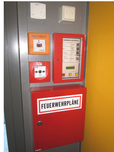
Brandmeldeanlage am Bahnhof Laubenbachmühle
